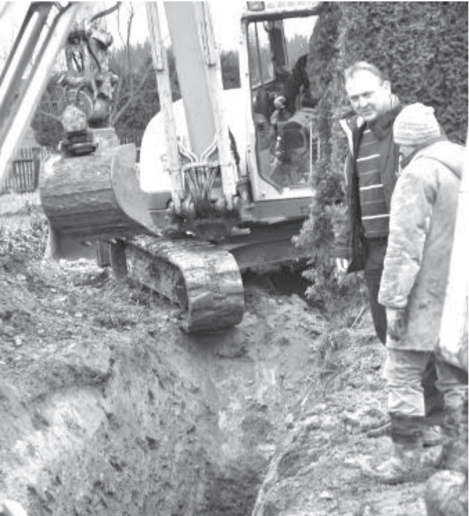
Starosta Petr Bárta na stavbě kanalizace – foto z 19. XII.2016
